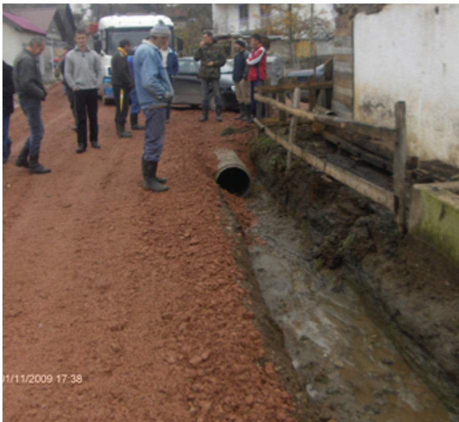
Radovi na putu Striježevo - Kokošćići
