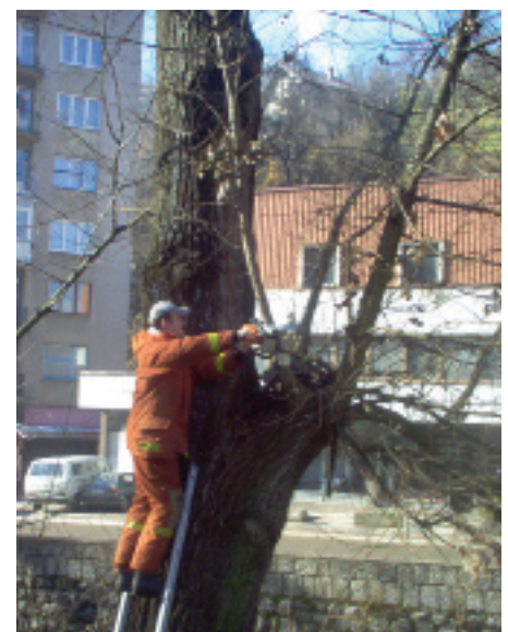
Uklanjanje polomljenog drveća
